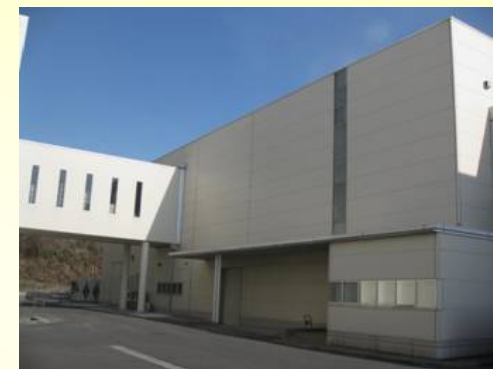
高萩工場第3製剤棟内に設置
